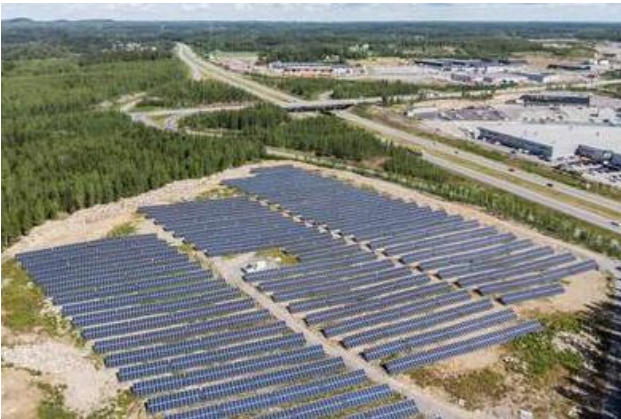
Aurinkopaneelikenttä Lempäälässä (Kuva: Aamulehti Yle)
